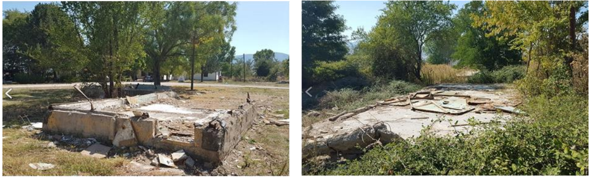
Εικόνα 4: Υφιστάμενη κατάσταση οικοπέδου
