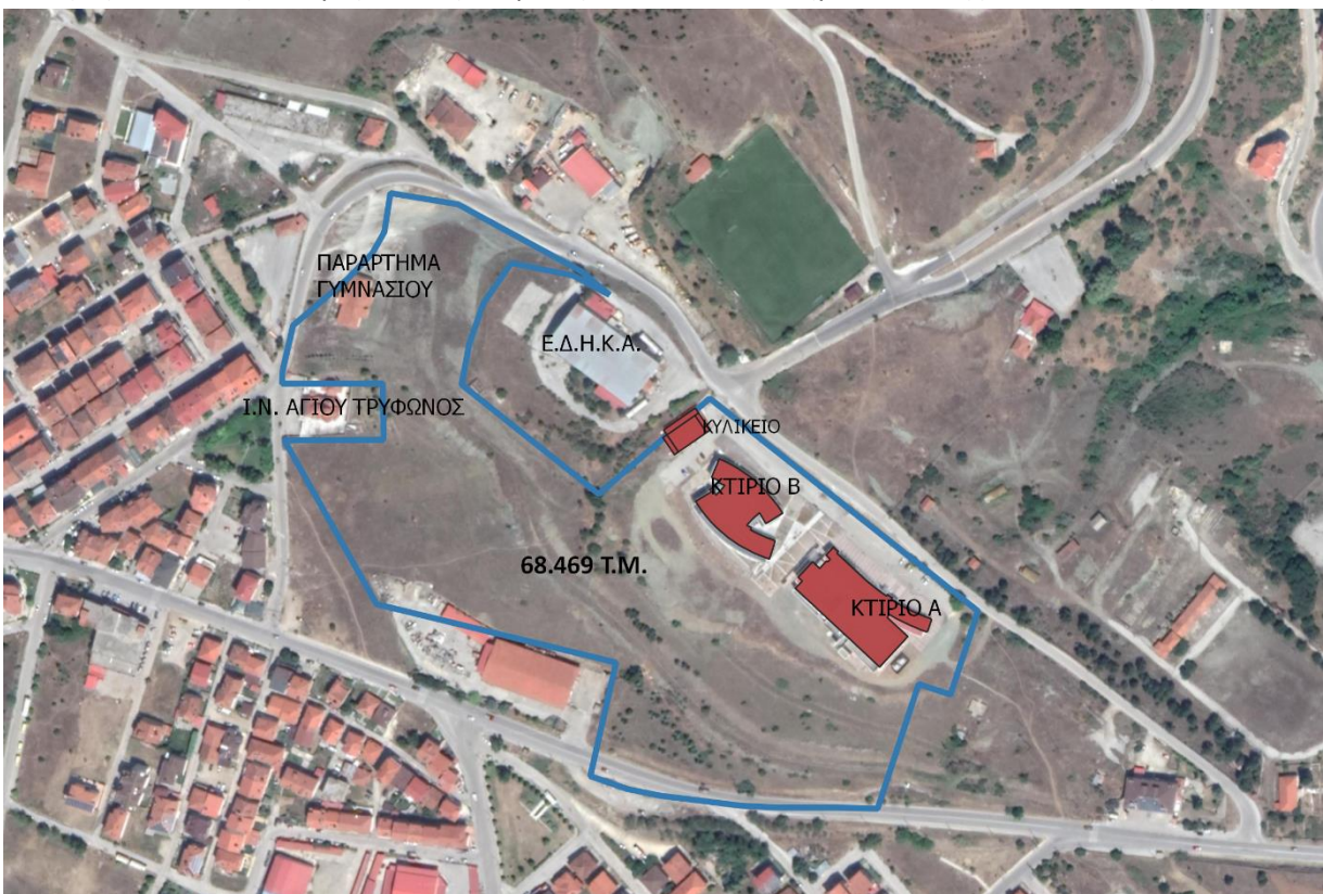
Εικόνα 2 Κτηριακές εγκαταστάσεις ΠΔΜ στην Καστοριά (πηγή υποβάθρου: Google Maps)
